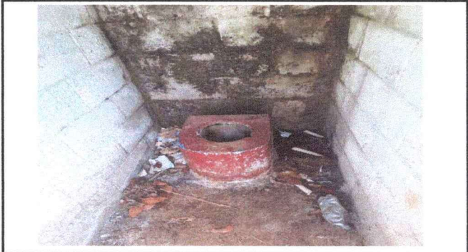
Foto 2: Mejoramiento de servicios sanitarios y sus accesorios
